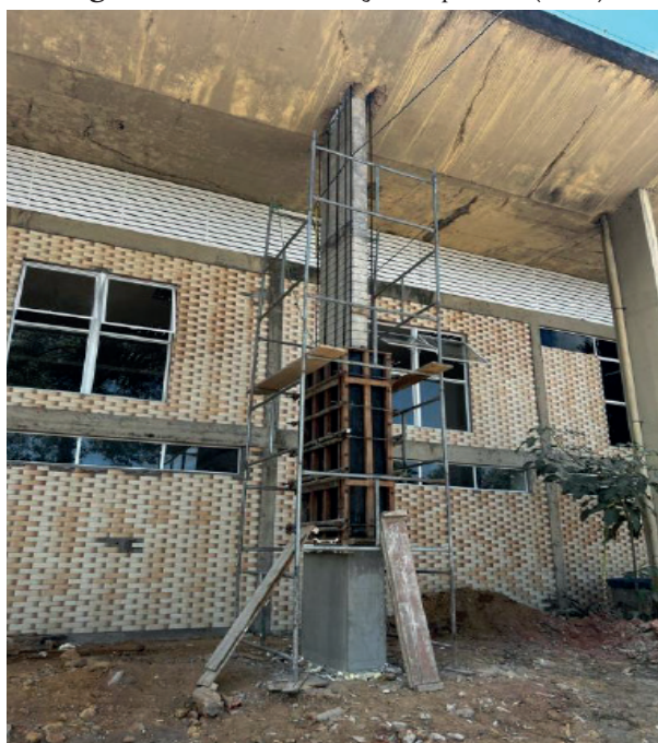
Figura 10: Autora, Reforço dos pilares, (2024)
