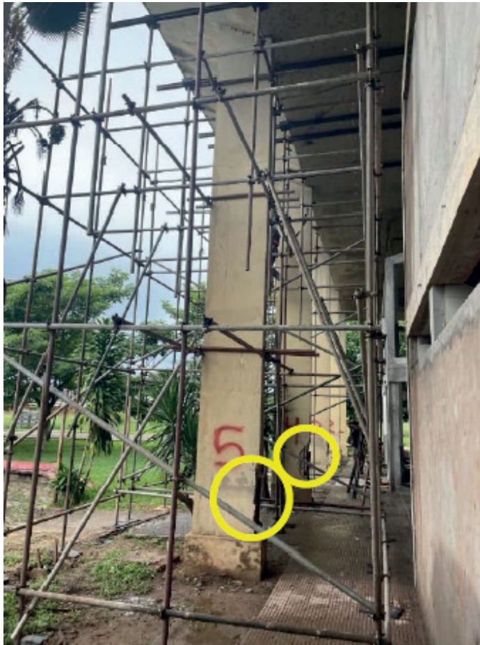
Figura 6: Autora, Estrutura escorada (2024)
