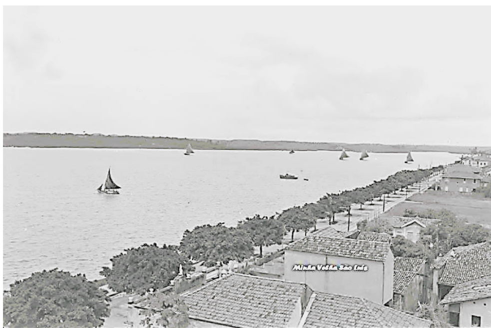
Figura 16: Vista da Avenida Beira Mar
