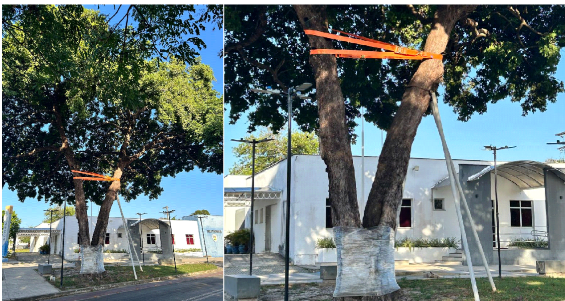
Figura 19: Amarração e escoramento de árvore com trinca no tronco.
