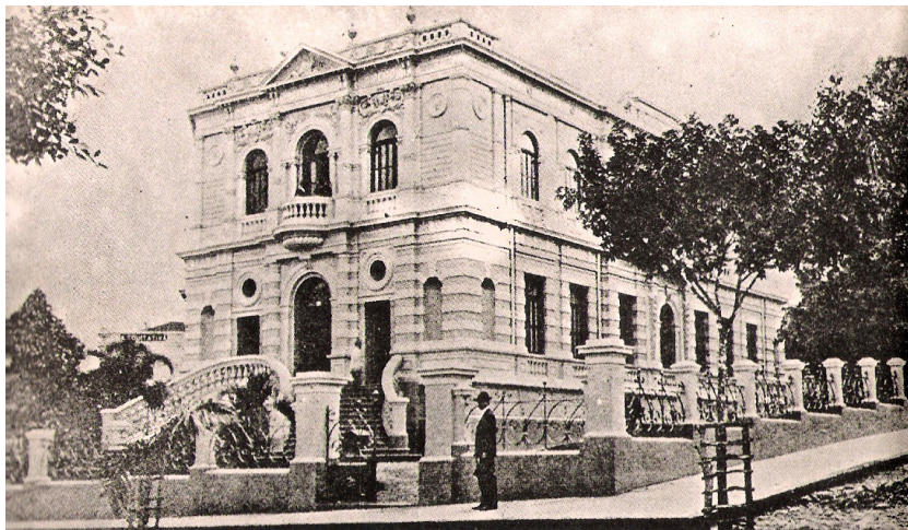
Figura 2 – Edifício da Faculdade Livre de Direito em Belo Horizonte, demolido em 1958 para a construção da atual sede da instituição na Praça Afonso Arinos.
