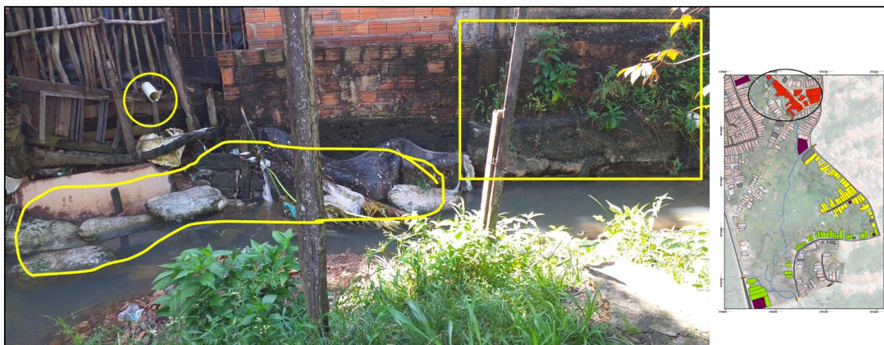
Figura 52: Situação da 1ª Travessa da Rua 6 de Abril, setor 10.
