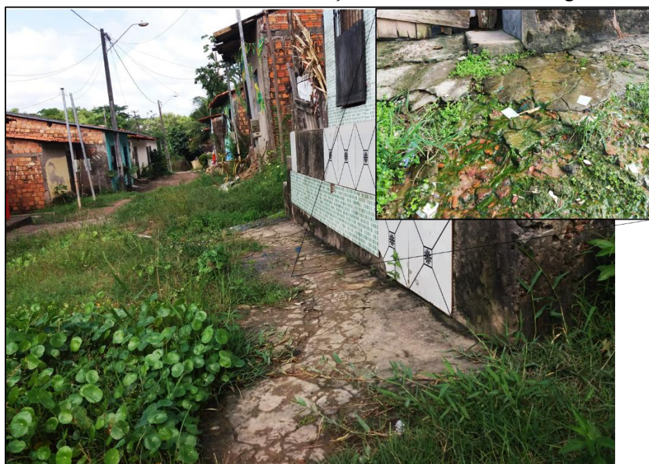
Foto 29: Vazamento de tubulação de abastecimento de água
