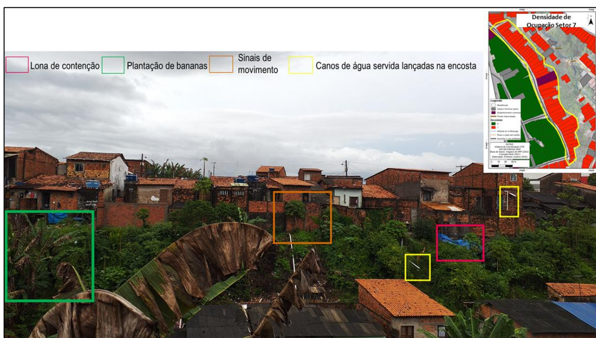
Figura 43: Densidade de ocupação do Setor 7, com destaque para lona de contenção improvisada na encosta, plantação de bananas, muro com sinais de movimento e canos de lançamento de água servida na encosta.
