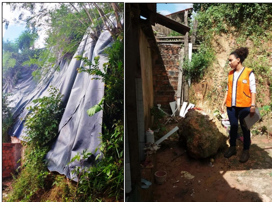
Figura 5: Deslizamento planar na área de estudo à esquerda. Figura 6: Queda de rochas na área de estudo à direita.
