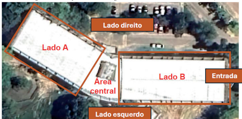
Figura 1: Adaptado do Google Earth, Prédio do SENAI , (2024)
