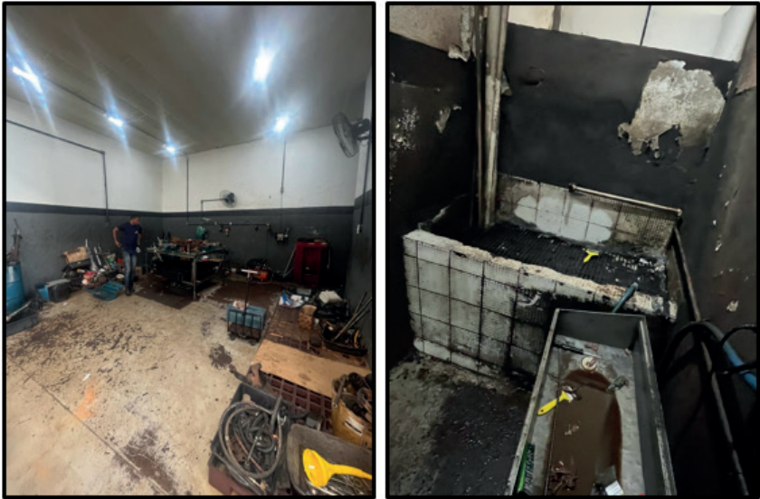
Figura 07 – Sala de montagem sem renovação de ar (esquerda) e lavador de peças semi-confinado e sem exaustão (direita)
