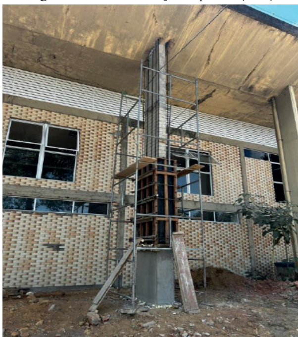
Figura 10: Autora, Reforço dos pilares, (2024)
