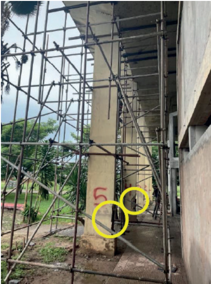
Figura 6: Autora, Estrutura escorada (2024)
