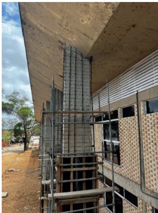
Figura 9: Autora, Barras posicionadas aguardando concretagem, (2024)
