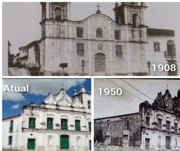
Figura 23: Fachada da Igreja São José do Desterro.
