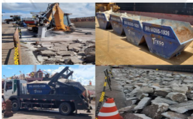
Figura 1: Execução do PGRCC.
