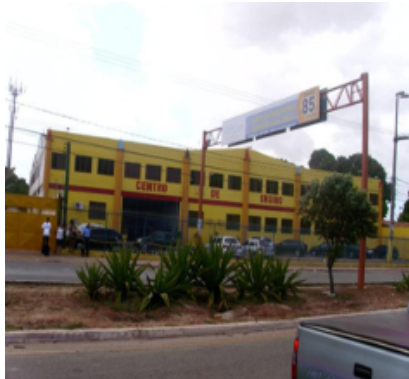
Figura 1. Fachada da escola.
