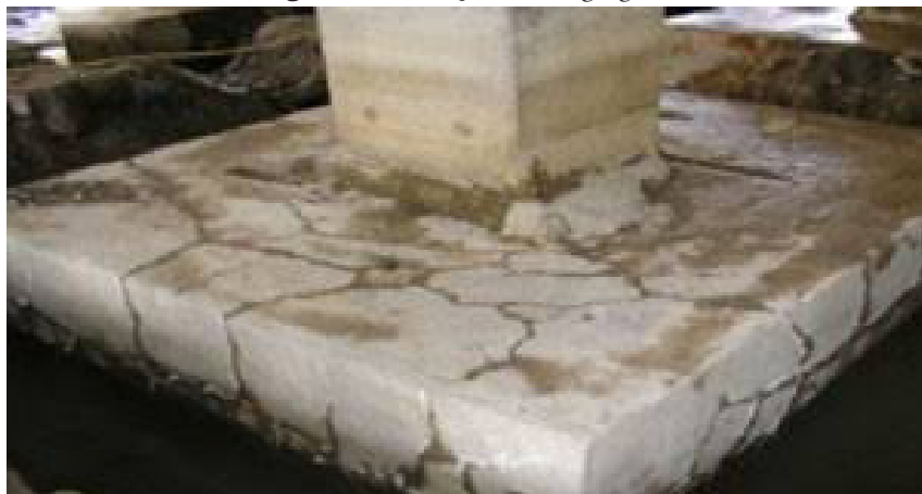
Figura 19 – Reação álcali agregado
