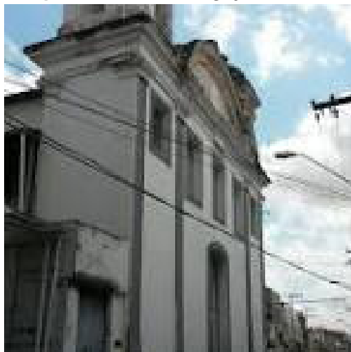
Figura 41 – Fachada da igreja de Santana
