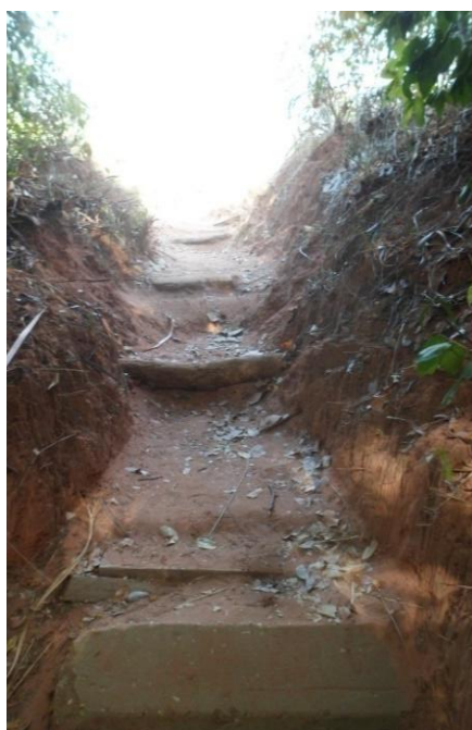
Figura 7- Descida de acesso a Cachoeira do Dodô
