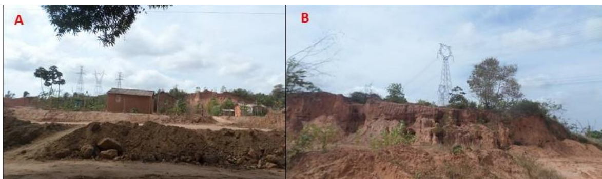
Figura 4 – Voçorocas na linha de transmissão de energia município de São Luís: A. BR 1; B. BR2
