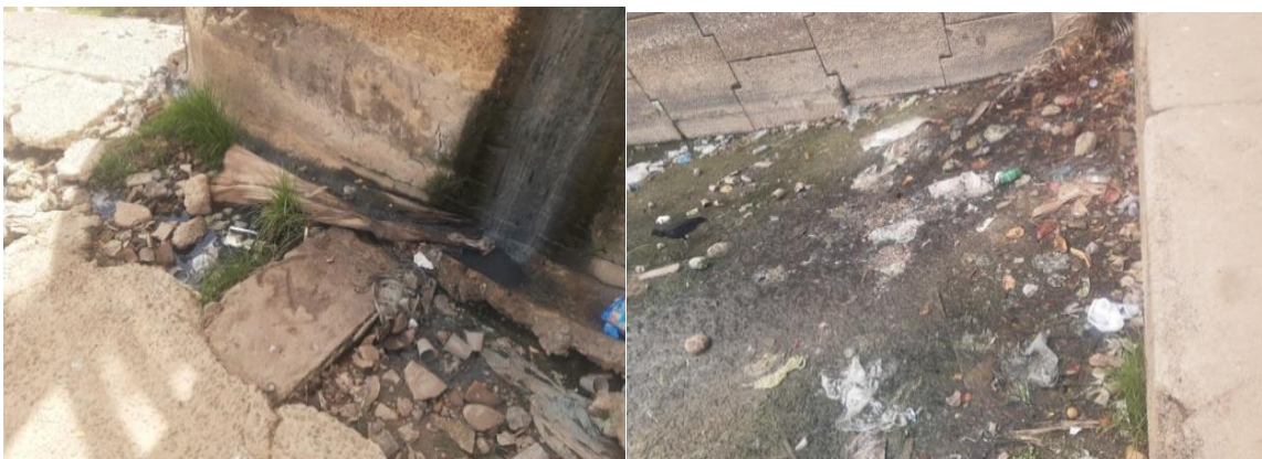
Figura 11 e 12: Esgotos In Natura e Resíduos Sólidos direto no Rio
