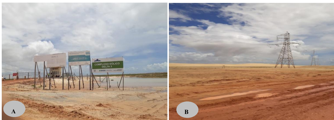
Figura 2 – Empresa de Energia Eólica – Ômega Energia: A – Área de acesso e B – Instalações no Parque Eólico.
