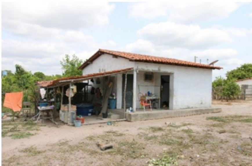
Figura 1 – Casa do PMCMM com construção de alpendre
