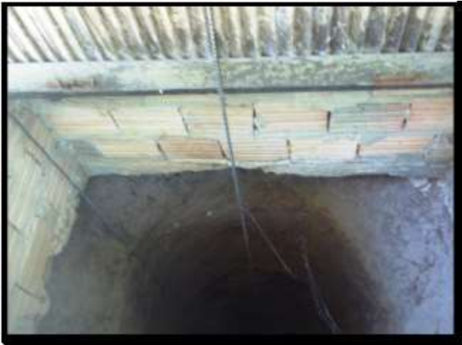
Foto 1: Poço cacimbão individual na comunidade Vila Guará (escavado). Fonte: Registro de pesquisa, 2012.
