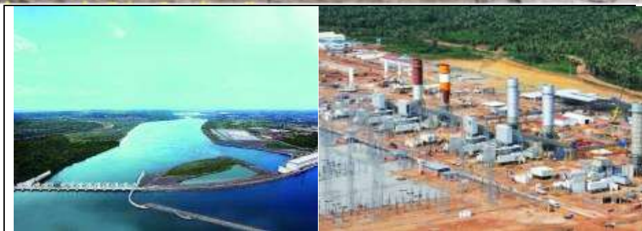
Figura 07 e 08 - Hidrelétrica de Estreito e Usina Termelétrica a Gás de Santo Antonio dos Lopes.
