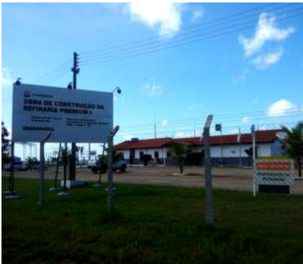
Figura 1: Instalações existentes no canteiro de obras iniciais da Refinaria Premium I da PETROBRAS – Bacabeira – MA.
