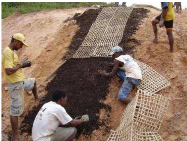
Figura 07: Aplicação dos geotêxteis e insumos.
