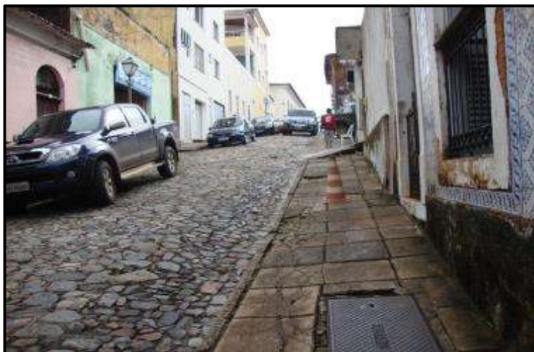
Foto 3: barreira arquitetônica / calçada com buracos com inclinação acentuada no Centro Histórico
