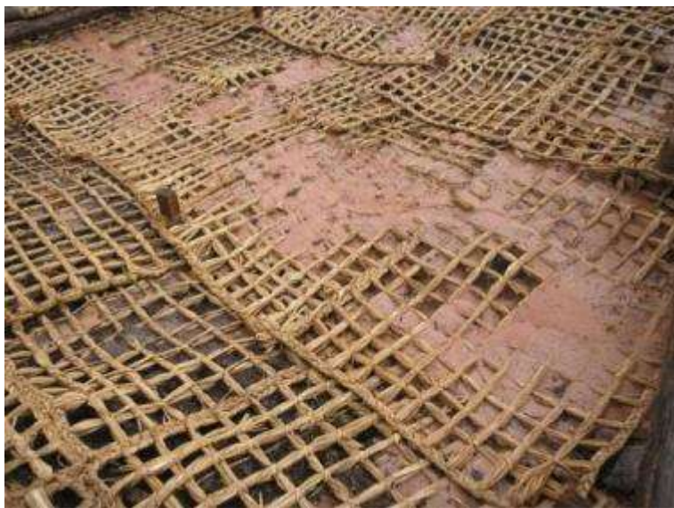
Figura 08: Contenção dos sedimentos pelos geotêxteis na voçoroca do Sacavém.
