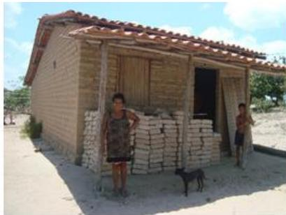
Figura 6 – Casa de adobe com inserção de telhas cerâmicas na cobertura. Fonte: Autora, 2016.
