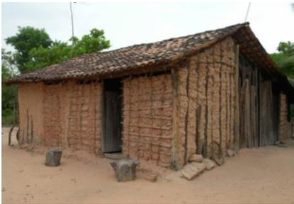
Figura 3 - Moradia Tradicional construída em taipa; cobertura de telha de barro; utilização de madeiras de espécies do cerrado - Carolina-MA. Fonte-ARQUES, 2009.
