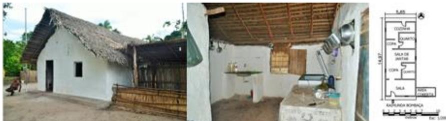
Figura 9. Moradia de taipa de mão no Povoado Tamanduá, Aldeias Altas. Vista frontal da casa, cozinha com instalação de água e planta baixa do imóvel
