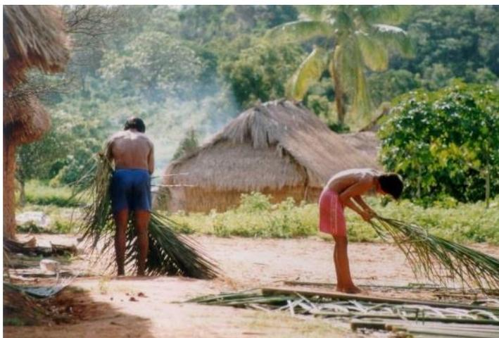
Foto 4: Tratamento da palha do coqueiro para a construção do teto da casa. Fonte: Rose Panet, 1999.
