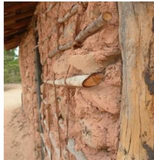
Figura 4 - Parede de Taipa, construção em terra do local, utilizando espécies arbóreas do Cerrado - Carolina - MA. Fonte - MARQUES, 2009.
