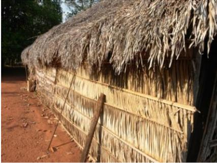
Figura 1- Parede de Moradia Tradicional construída em fibra de palmeiras - Carolina-MA. Fonte - MARQUES, 2009.
