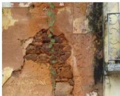
Alvenaria em pedra argamassada com cal.
