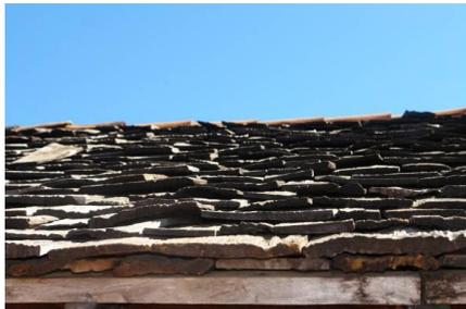
Figura 6– Detalhe do telhado de cavaco de madeira de Bacuri; é construída em sistema intercalado, um sobreposto ao outro, que impede a passagem de água da chuva, com alta durabilidade (em torno de 25 anos, segundo informações obtidas no local junto ao morador). Fonte – MARQUES, 2010.
