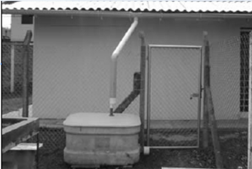
Figura 3. Sistema de Coleta e Captação de Água de Chuva
