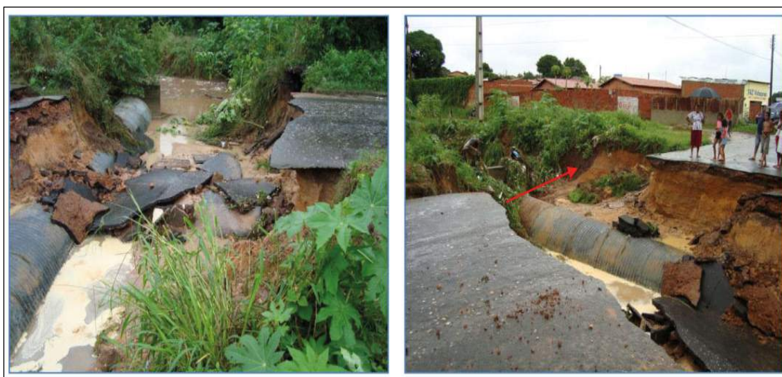
Figura 3. Erosão Hídrica em bueiro rompido na Rua Celso Pinheiro.
