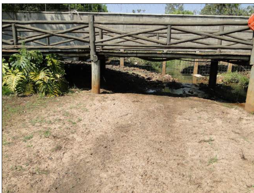
Figura 6. Presença de assoreamento em lago no município de Bauru - SP, registrado em 2017. Notar o grande volume de sedimentos depositados.
