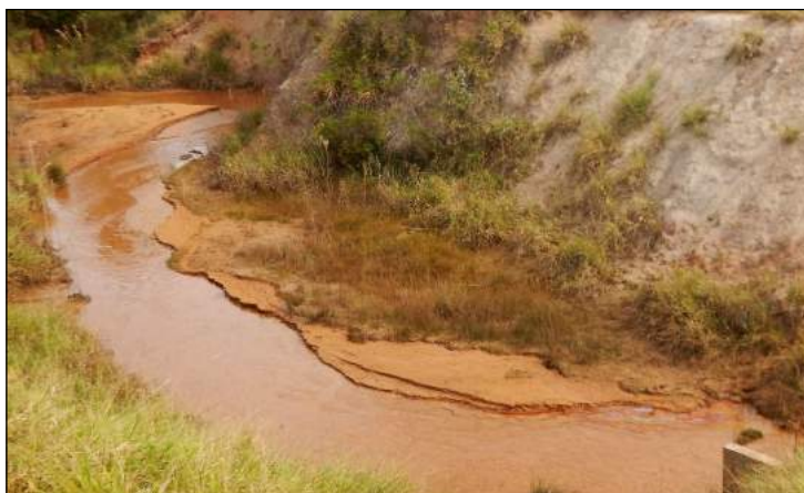
Figura 2. Assoreamento em corpo d'água, no município de Avaré em SP, registrada em 2019. Observar o solo arenoso depositado no pé do talude.
