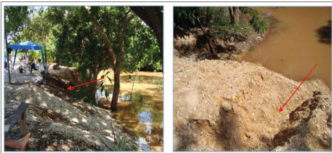
Figura 4. O colapso de bueiro provocando um princípio de erosão no talude da Av. Maranhão, Teresina.
