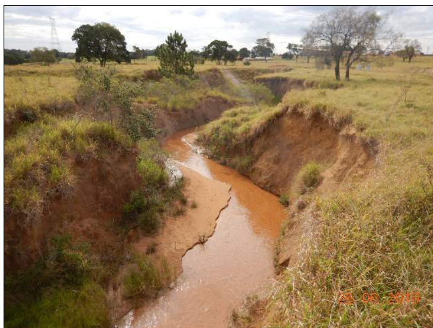
Figura 4. Ocorrência de boçoroca em área rural do município de Avaré-SP, observada em 2019.
