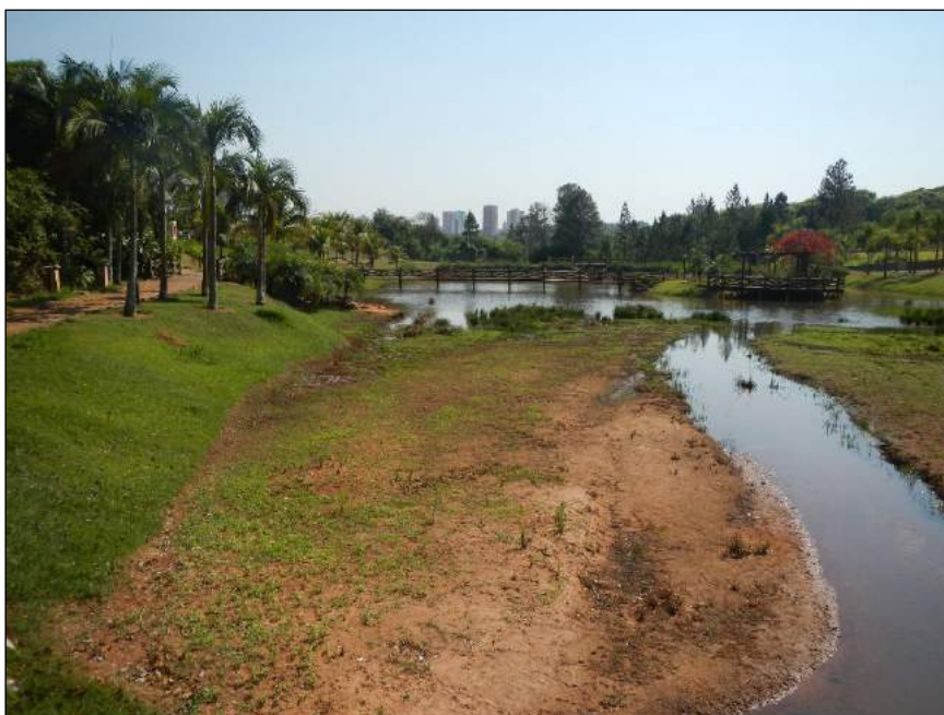
Figura 5. Assoreamento em lago de empreendimento no município de Bauru - SP, observado em 2017. Notar o grande volume de sedimentos depositados no leito do corpo d'água.
