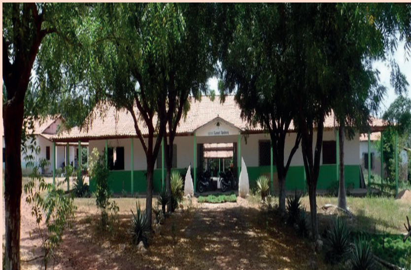
Foto 1 - Frente da CEFFA Manoel Monteiro (Lago do Junco)
